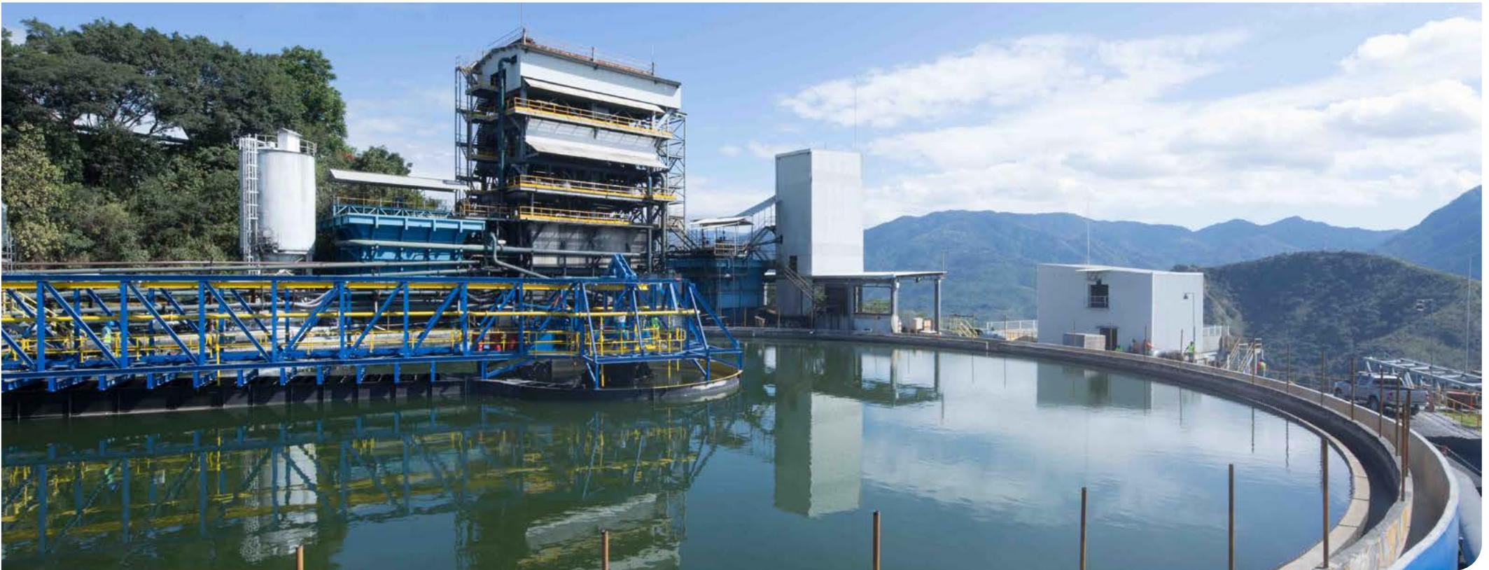
EL TANQUE ESPESADOR AE-96, CON 60 METROS DE DIÁMETRO, TIENE CAPACIDAD DE PROCESAR POR HORA 7,800 TONELADAS DE JALES Y AGUA EN USO.
