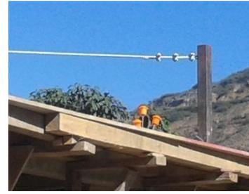
Las abrazaderas deberán estar posicionadas con el lado de la silleta sujetando el cable vivo (Sección 8.4.3 NOM-009-STPS-2011). No deberán existir tramos de cable superiores a los 20 m e inclinación mayor a los 15°. La resistencia de todo el sistema debe superar los 2,700 kg y ser utilizados por no más de dos personas a la vez. Toda línea de vida horizontal debe ser autorizada por seguridad antes de su uso.
